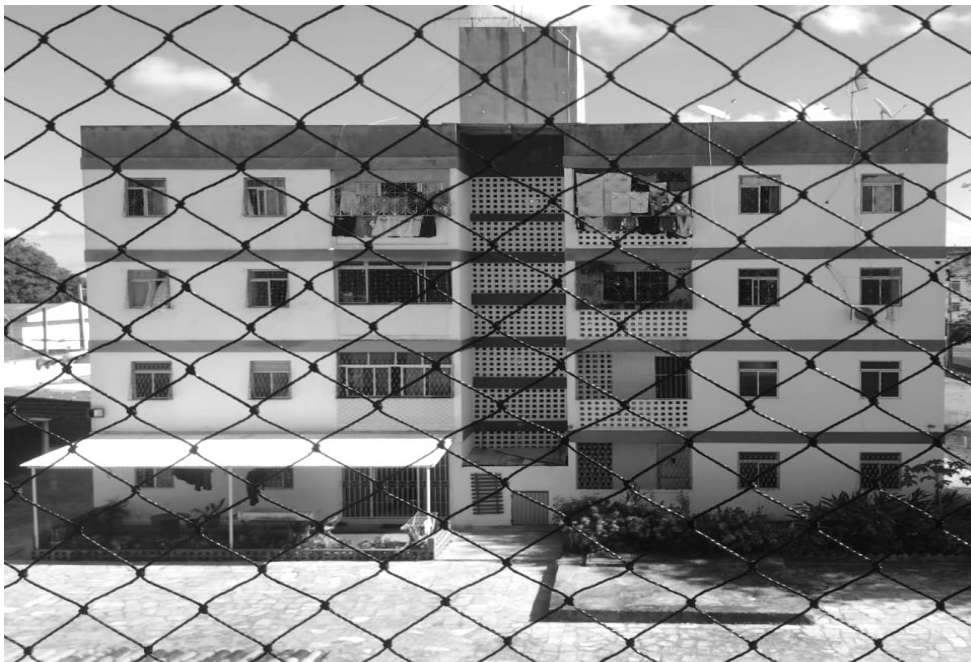
Figura 02. Residencial X3 visto do janelão da varanda do X2, no segundo andar.
